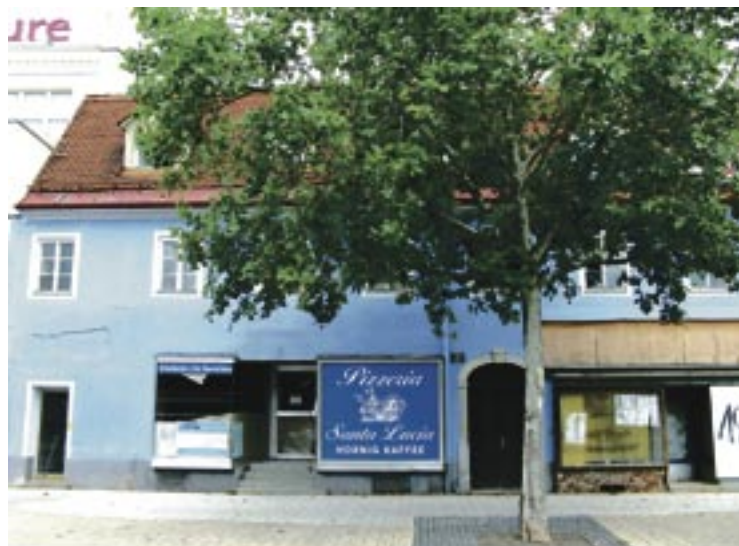
Neuer Zankapfel: Das Haus Lendplatz 38 soll einem Neubau weichen. Die Altstadtkommission ist dagegen, SPÖ und ÖVP sind dafür.
