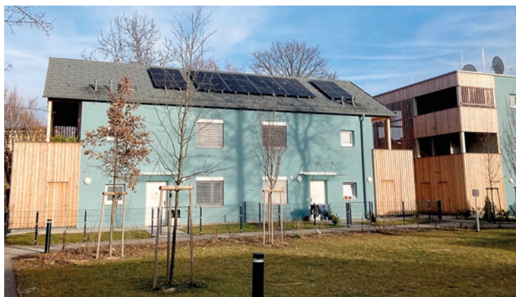
In Zusammenarbeit mit der Energie Graz wurden die neuen Gemeindewohnhäuser Am Grünanger mit Photovoltaikanlagen ausgestattet
