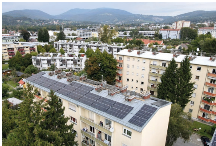
Die Photovoltaikanlage als Pilotprojekt in der Schippingingerstraße spart Geld und Energie.
