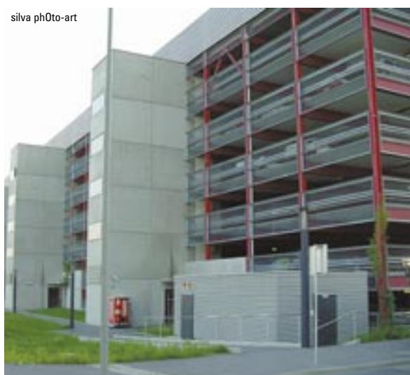
Ohne Vorwarnung: Arbeiter standen vor verschlossenen Parkhaus-Türen.
